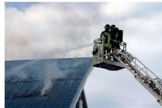
Incendi impianti fotovoltaici
