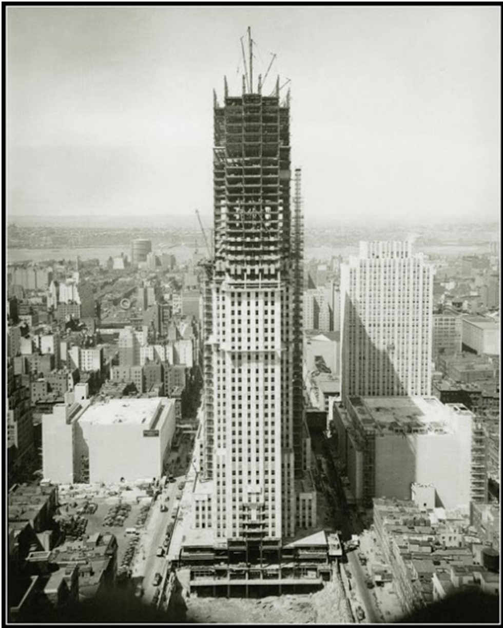
LA COSTRUZIONE DELL'EMPIRE STATE BUILDING (THE BUILDING OF THE EMPIRE STATE C. WILLIS).
